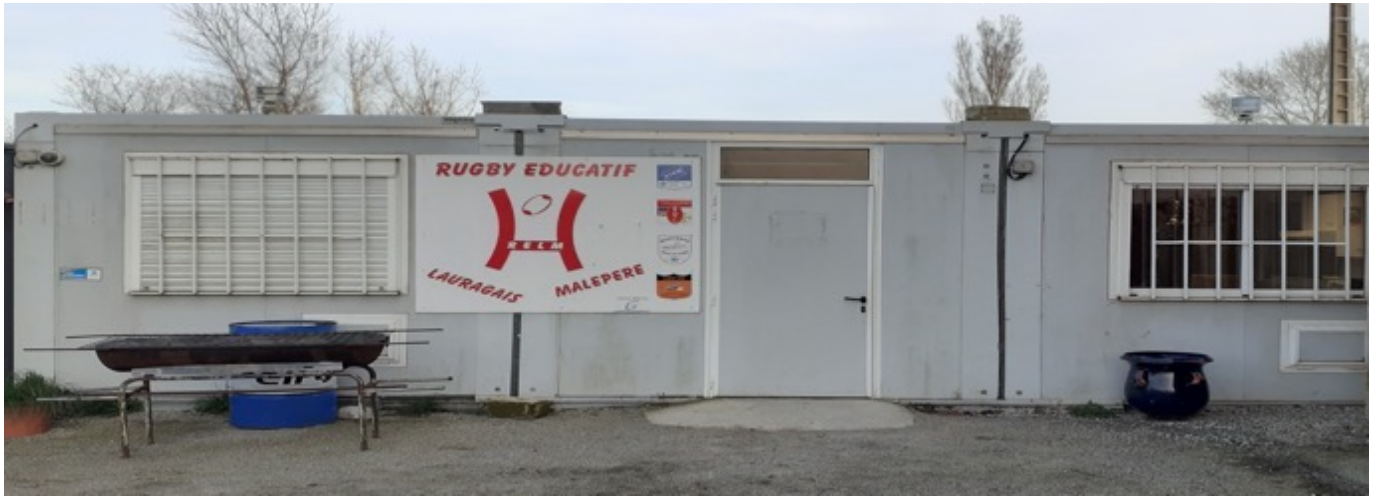
Accès au local du RELM
